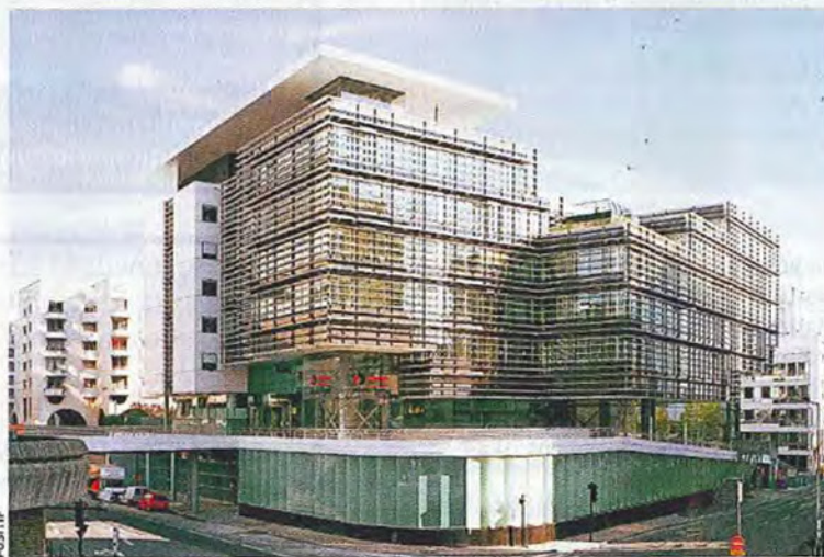
Le nouvel immeuble administratif Gironde, dans le quartier Mériadeck, accueille 800 agents du département.
