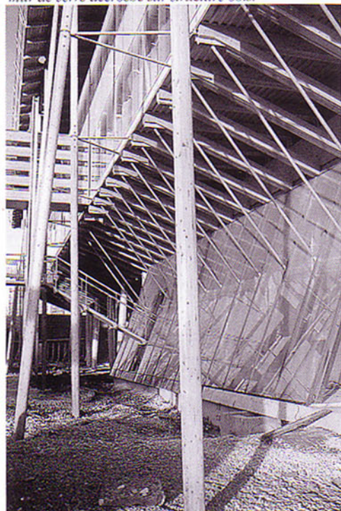
Poteaux-crayons soutenant la sur-toiture, en premier plan, telle une verrière, l'accueil et la bibliothèque.
