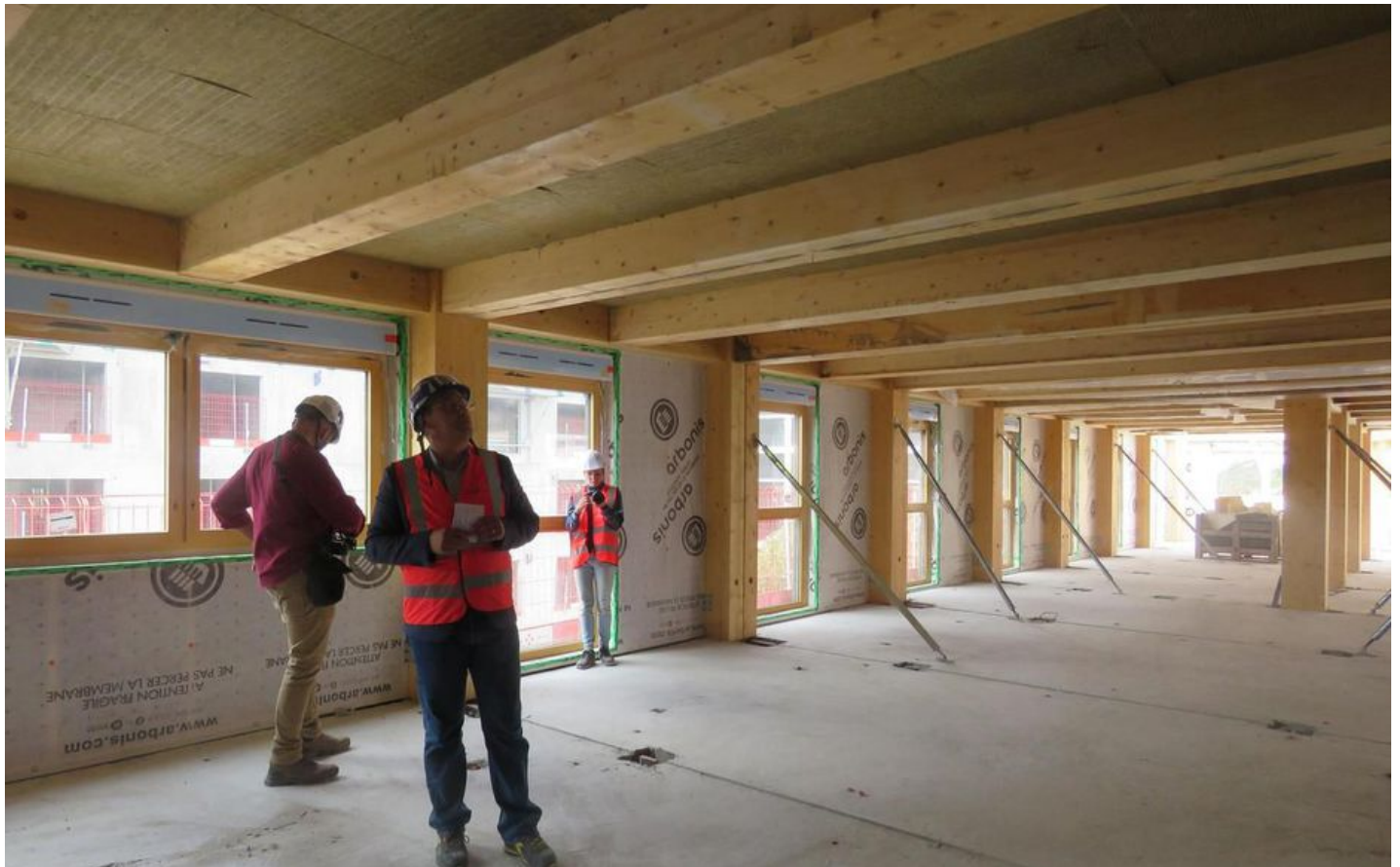
Champs-sur-Marne, ce vendredi 13 septembre. Cette tour à ossature bois fait partie d'un ensemble de 23 000 m 2 , composé de cinq bâtiments. LP/Julie Olnagol
