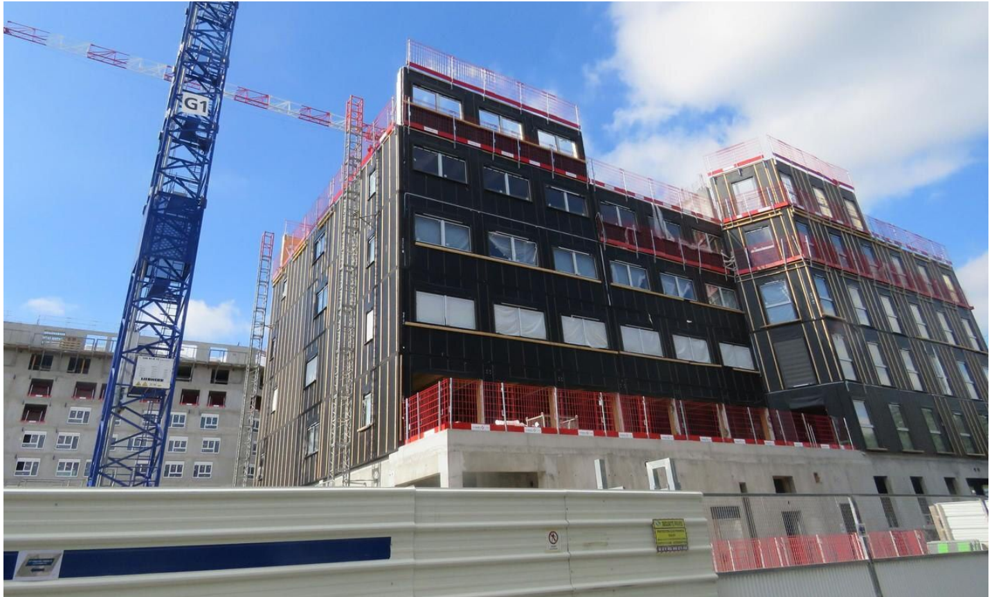
Champs-sur-Marne, ce vendredi 13 septembre. Cette tour à ossature bois fait partie d'un ensemble de 23 000 m 2 , composé de cinq bâtiments. LP/Julie Olgagnol
