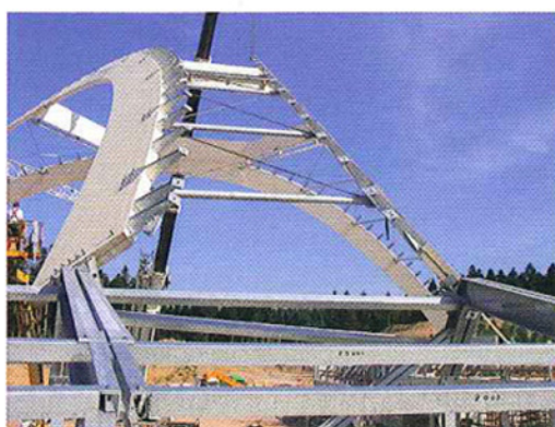
▼ Montage de la structure en lamellé-collé constituant le support de la voûte translucide. Les arches sont inclinées en se rapprochant du centre pour donner une certaine souplesse à la forme.
